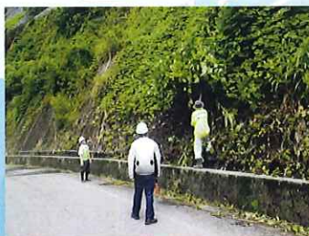
樹木の伐採作業
